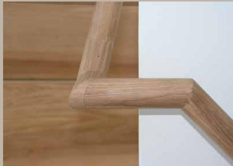
Die Handläufe wurden ebenfalls mit massiver Eiche angefertigt.
