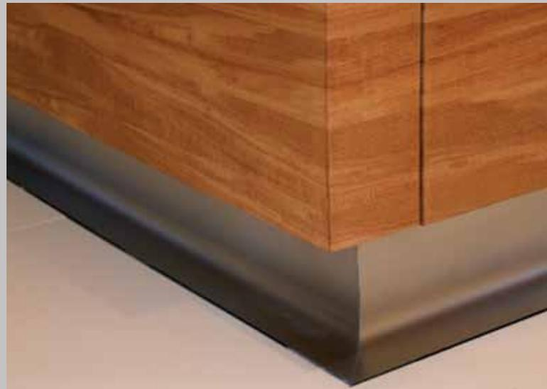
Die Küche und der Raum insgesamt haben einen massiven Edelstahlsockel mit einer Kehle für leichteres Reinigen.
