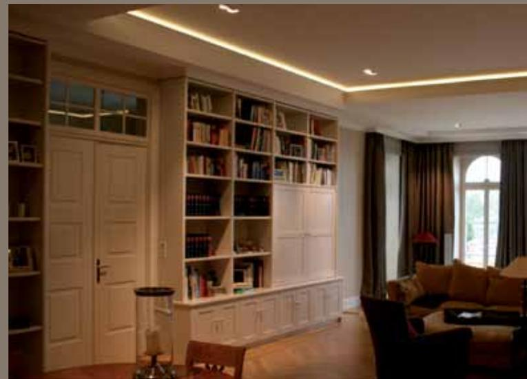
Integrierter Medienschränk mit Drehschiebetüren, welche nach dem Öffnen in den Schrank geschoben werden. Die Zimmertüren sind auf die Einbauten abgestimmt und in Handarbeit weiß lackiert.
